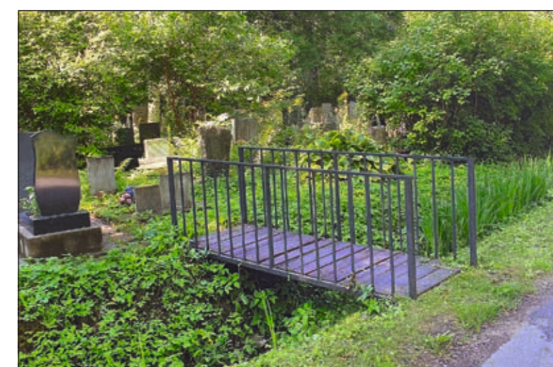
Мостик через дренажную канаву
